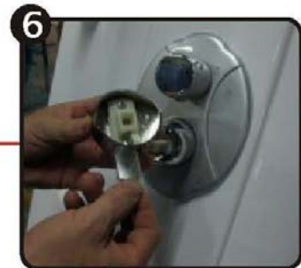
6 Установите винт клапана смесителя.
