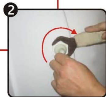
2 Установите форсунки в среднюю стену.
