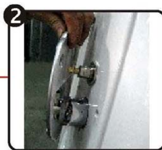
2 Установите крышку смесителя.
