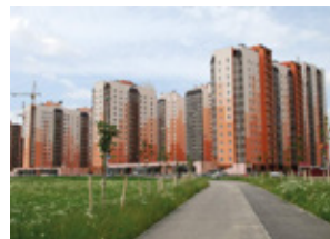
Объект: ЖК «Новый Оккервиль», г. Санкт-Петербург, д. Кудрово Поставщик : ООО «Денеб»
