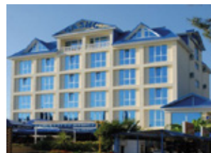
Объект: Гостиница «Оазис», г. Сочи Поставщик : ООО «Теплосервис»
