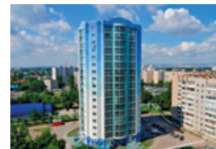
Объект: Монолитно-каркасный дом, г. Энгельс, ул. Тельмана, 6д Поставщик : ООО «Сантехкомплект»
