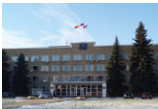
Объект: Здание администрации, г. Щелково Поставщик : ООО «Базис ТСС»
