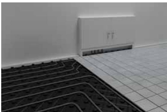
Рис. 3. Система теплого пола с использованием системы PE-RT TEBO ® . Трубы PE-RT значительно более гибкие, чем PE-X, их легко уложить «змейкой» без дополнительных инструментов
